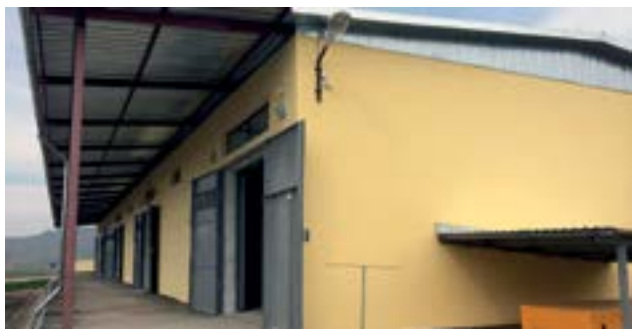
По линии осуществляемой Центром ОБСЕ в Бишкеке программы, касающейся легкого и стрелкового оружия и обычных боеприпасов, была оказана поддержка в реконструкции складов вооруженных сил Киргизии и в строительстве нового склада, подведомственного военной части, в деревне Кой Таш, расположенной в 20 км от Бишкека (ОБСЕ/Василина Бражка)
