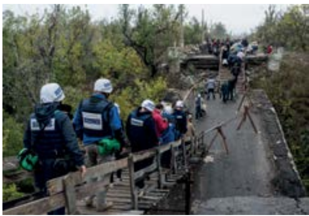
Сентябрь 2016 года, станция Луганская. Наблюдатели СММ у разрушенного моста (ОБСЕ/Евгений Малолетка)
