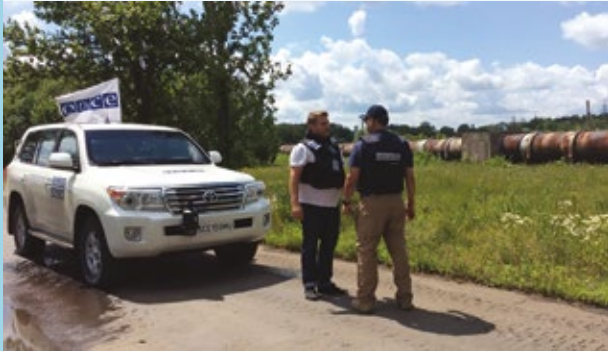
Сотрудники СММ содействуют ремонту водопровода близ Горловки Фото: Клифф Волле (ОБСЕ)
