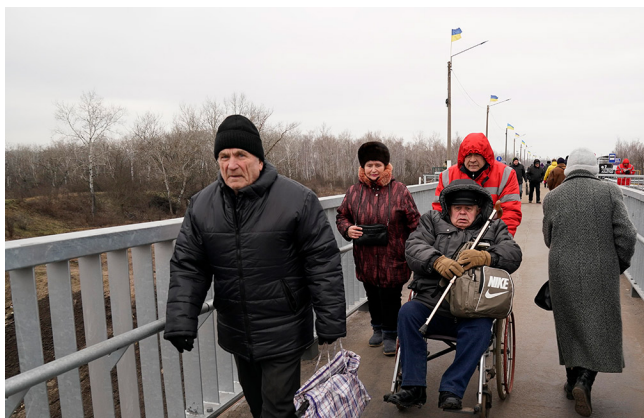
Мост у Станицы Луганской после завершения ремонтных работ в ноябре 2019 года
