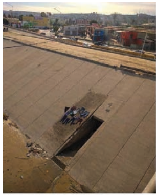
Troneras para el desagüe en la construcción del río Tijuana, con ropas secándose al sol, Tijuana, diciembre de 2019.
