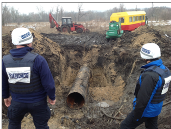
Рисунок 1. Патруль СММ здійснює моніторинг ремонтних робіт на магістральному водогоні біля Петрівської насосної станції в н. п. Артема, Луганська область, січень 2017 р.
