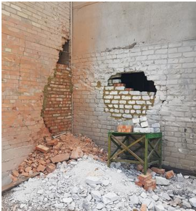
Ремонт поврежденной стены главного корпуса насосной станции в Киевском районе Донецка, май 2021 г.
