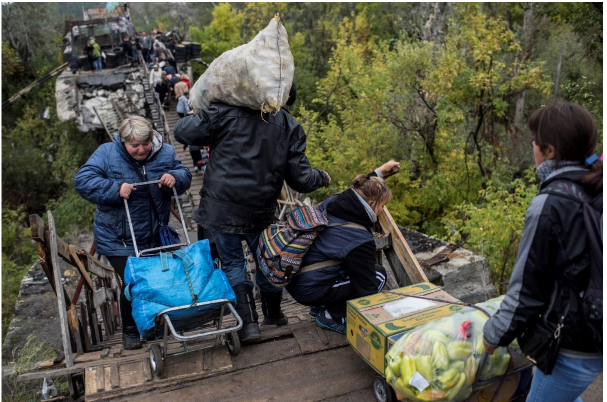
Зруйнована секція мосту біля Станиці Луганської до ремонту, квітень 2019 р.
