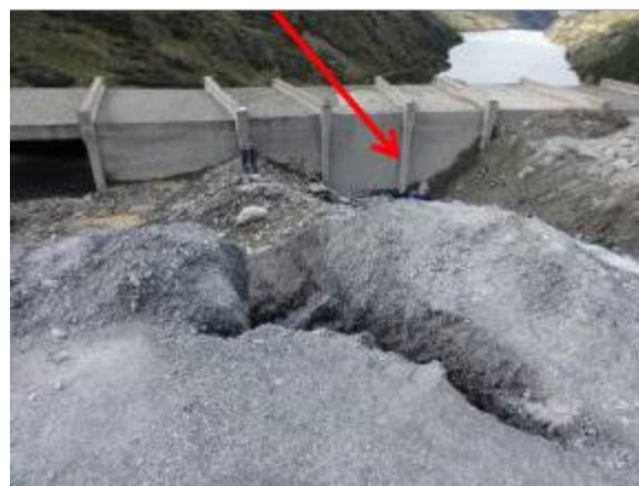
Рисунок 11: слева: зона, видимая с дороги, расположенная непосредственно под источником опасности / справа: тоннель с усиленной железобетонной частью (красная стрелка) и область кладки, которая была разрушена.
