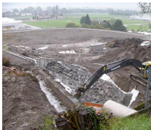
Рисунок 17: Строительство сдерживающего бассейна в 2003 году
