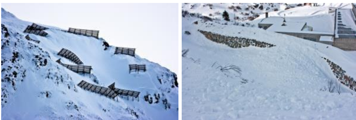
Рисунок 10: слева - металлические заграждения, построенные в зоне начала схода лавины, угрожающей входу в тоннель / справа - сдерживающая дамба, построенная в нижней части прямо над входом в тоннель в зоне приостановки схода лавины.
