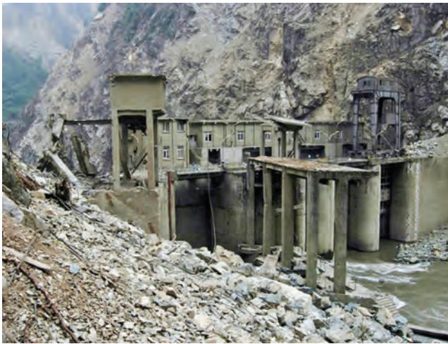
الشكل ٣٩. محطة جيندا المتضررة للطاقة المائية (علي اليسار) والقريبة من المحطة الفرعية (علي اليمين) بالقرب من مركز زلزال وينشوان (Photo credit; Mingchong Liu).
