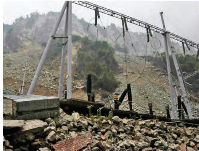
الشكل ٣٩. محطة جيندا المتضررة للطاقة المائية (علي اليسار) والقريبة من المحطة الفرعية (علي اليمين) بالقرب من مركز زلزال وينشوان (Photo credit; Mingchong Liu).
