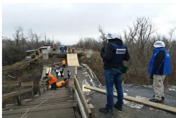
Ремонт деревянных конструкций моста в Станице Луганской, 9 декабря 2017 года (ОБСЕ)
