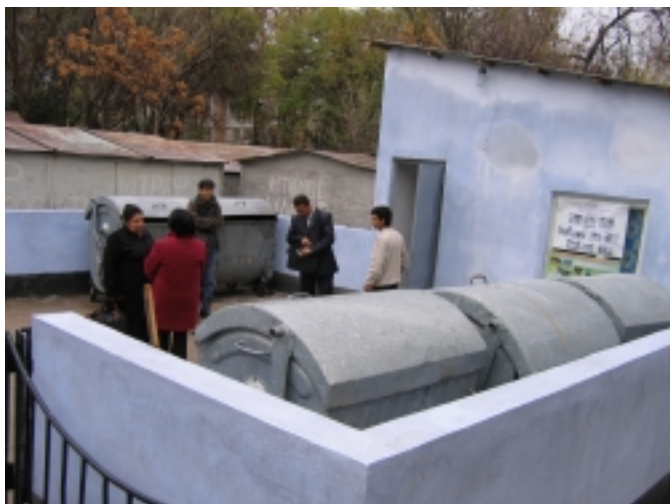
Фото Д. Зайнутдиновой Завершающий этап строительства площадки (ноябрь 2006 г.)
